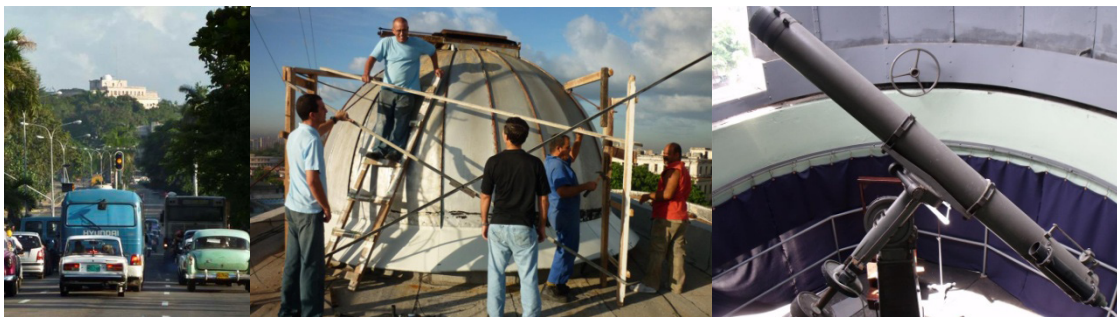
El punto más alto. A la izquierda: cúpula del Observatorio Astronómico de la Universidad de La Habana (al fondo, cerca del centro de la foto) visto desde la Avenida de Rancho Boyeros. Al centro: la cúpula rotatoria, en pleno proceso de restauración. A la derecha: Telescopio principal, un refractor Perkin-Elmer de 142 mm de diámetro y una distancia focal de 2372 mm de su lente objetiva, con montura ecuatorial. (Foto: M. de la Guardia)
