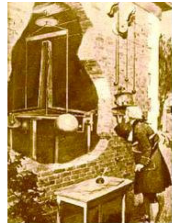
Figura 3. Lord Cavendish observando su experimento con la balanza de torsión. Este experimento fue considerado entre los 10 experimentos más bellos de la física según una encuesta realizada por la revista Physics World en 2002. ►
